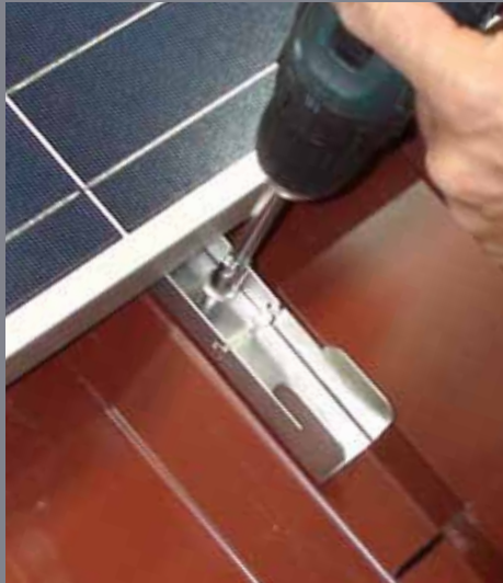
ilzohook Einbau mit Dünnblechschraube
